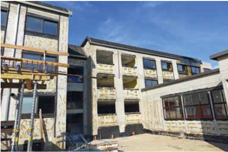
Heute noch Baustelle, bald einladender JUFA-Hotel-komplex.
