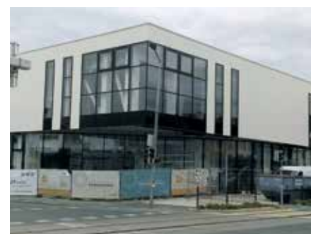
Der neue H&M-Markt nimmt Formen an.
