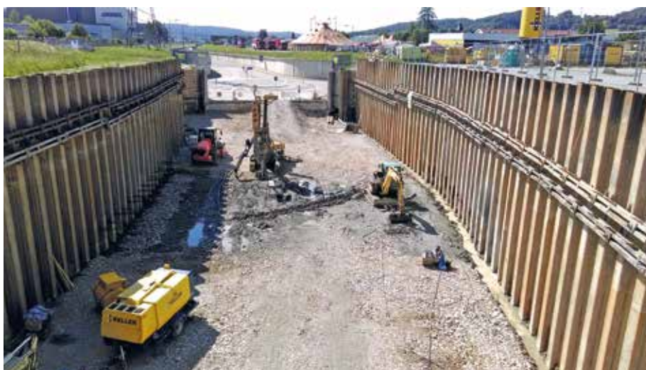
Baustelle ODF II: Errichtung der Bodenplatte und der Seitenwände.
